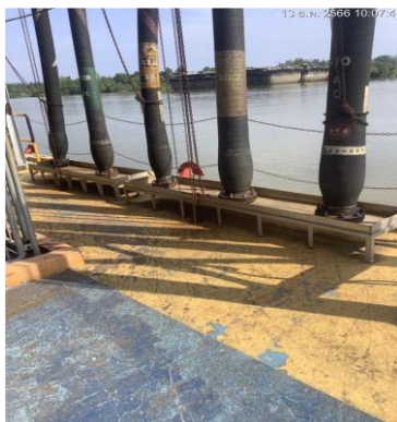
ภาพที่ 11 ถาดรองน้ำมันที่อาจรั่วหกและวาล์วที่ปิดกั้นน้ำมันปิดตลอดเวลาการขนถ่ายน้ำมันที่ทำ
